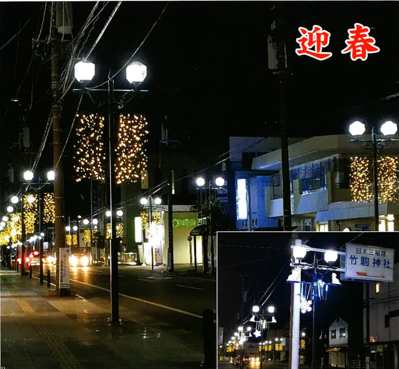
岩沼市中央通り商店街イルミネーション
